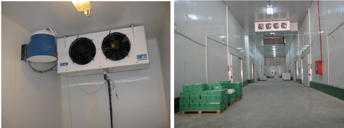
شكل (١٤). غرف تبريد حديثة (يمين) وجهاز التبريد بالماء يعمل بالتحكم الآلي لزيادة الرطوبة النسبية داخل المخزن (يسار). (المصدر: تصوير المؤلفين).
