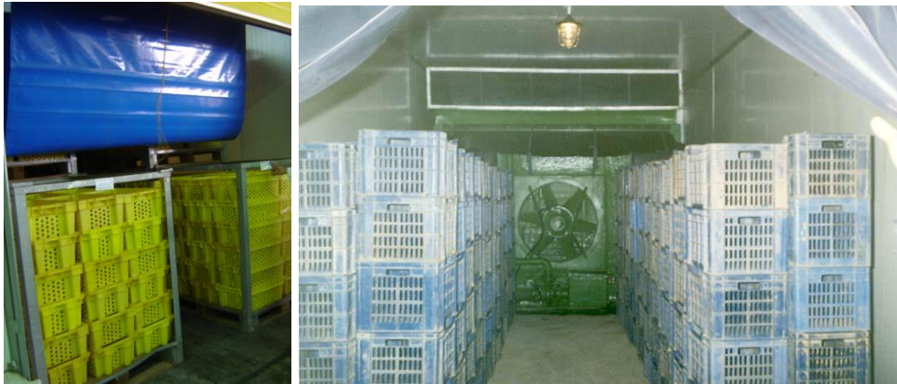
شكل (١١) غرف التبريد المبدئي وتظهر مراوح الهواء البارد المدفوع للتوزيع المنتظم لدرجة الحرارة بين عبوات المنتجات البستانية. (المصدر: تصوير المؤلفين).
